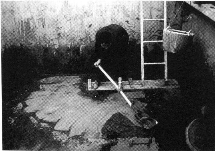
Photo 4 Nettoyage d'un filtre lent à sable
