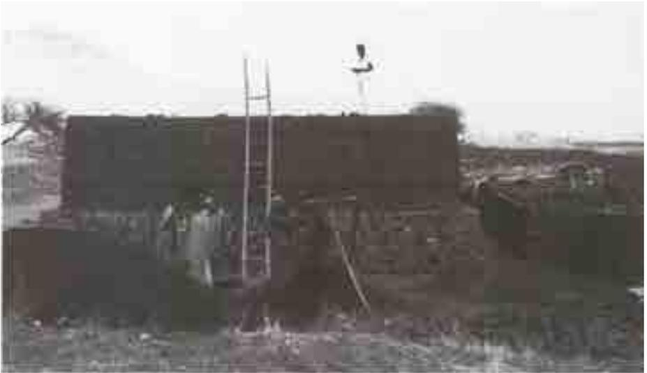
*Four de campagne typique en Inde: Du charbon broyé, tamisé à l'avant plan de la photo, est utilisé comme combustible. Sur la droite les briques crues sont stockées pour séchage. (Photo: K. Mukerji)*
