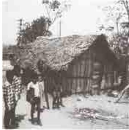
*Couverture typique en feuilles de cocotier, sur une maison à ossature en bambou, avec des murs habillés de bambou, Trivandrum, Inde (Photo: K. Mukerji)*
