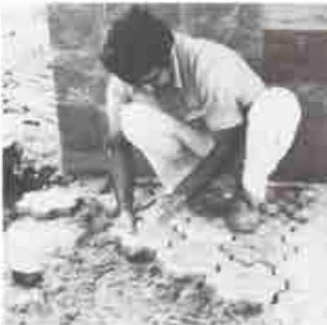
*Carreaux de pavement en béton de soufre, utilisés dans le cadre de l'«Ecol Operation» (Bibl. 18.06). Les carreaux de 5 cm d'épaisseur ont été fabriqués dans des moules en fer-blanc (moules ménagers pour la pâtisserie) et posés sur un lit de sable.*
