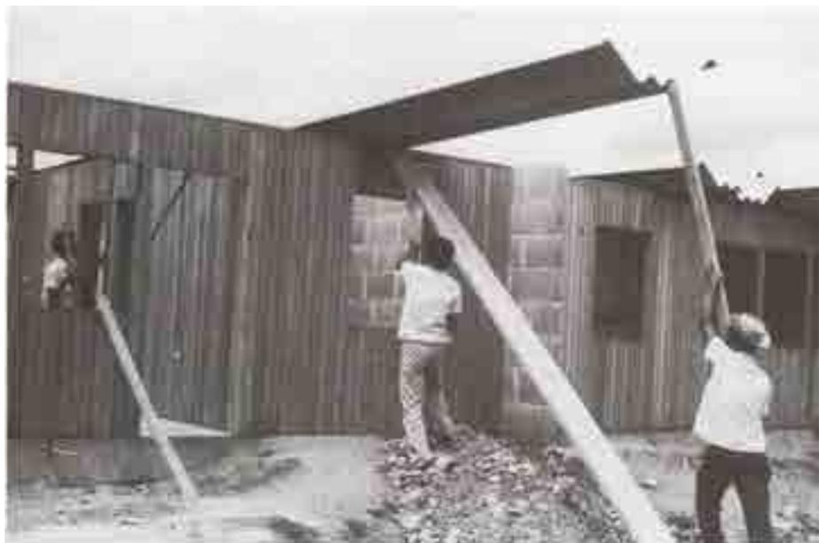
*Pose d'un bac autoportant à Tegucigalpa au Honduras, 1967: installation rapide par une main d'oeuvre non spécialisée (Photo: Alvaro Ortega, qui a développé ce système de couverture).*
