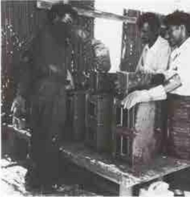
*Démonstration de l'emploi du soufre à Doubaï, aux Emirats Arabes Unis: moulage de blocs creux emboîtants en béton de soufre. (Photo: A. Ortega, Montréal)*
