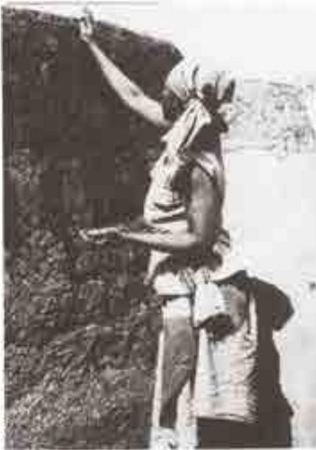
*Polissage de l'enduit sec à l'aide d'une pierre plate en basalte ou en granite*
