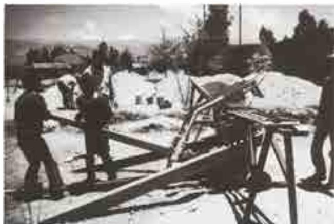
Précompression par la fermeture énergique du couvercle et par un coup de piston vertical. Des tables latérales facilitent les manipulations relatives au remplissage du moule et à l'évacuation des blocs.
