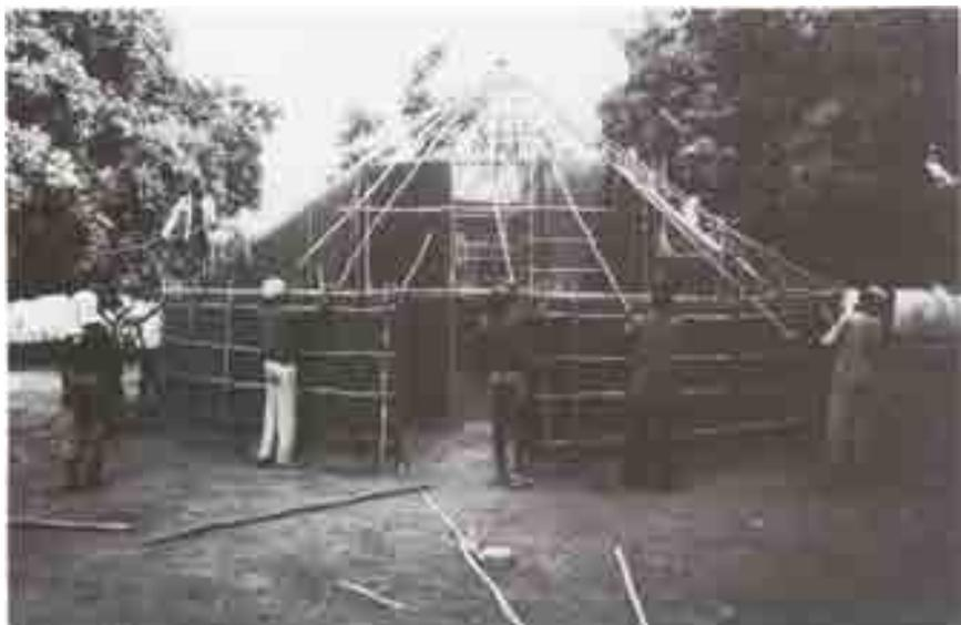
*Construction de l'ossature du toit en bambou, après achèvement des murs d'adobes renforcés de bambou*
