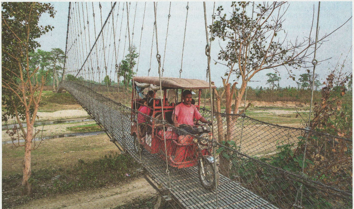
Eine der vielen Helvetas-Hängebrücken in Nepal: die Masanghat Trailbridge.
