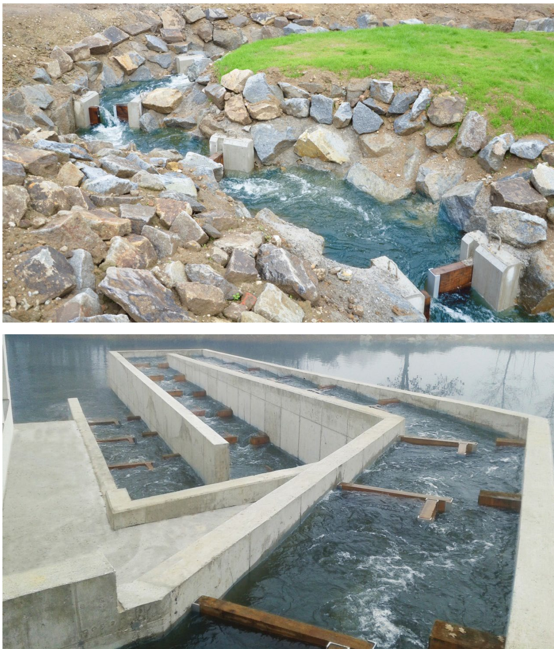
Fig. 4 Exemples d'une échelle à poissons naturelle (en haut) et d'une passe à bassins (en bas) 11
