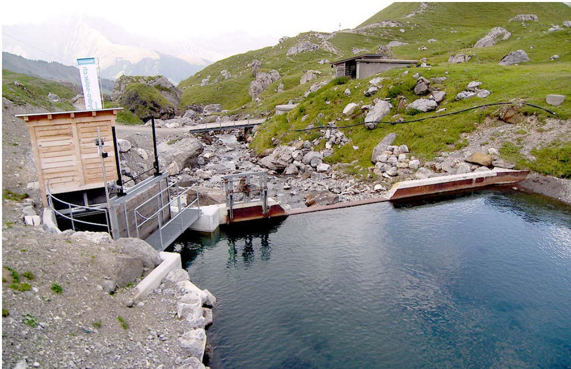
Fig. 5 Le seuil de l'ancienne installation et le dégrilleur (à gauche) 12
