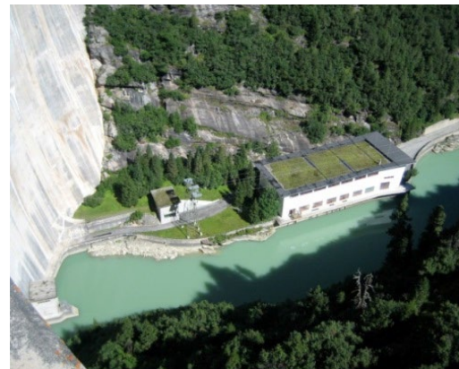
Abb. 11: Krafthaus am Fusse der Staumauer des Zervrailasees (Bauzeit bis 1957) [18]
