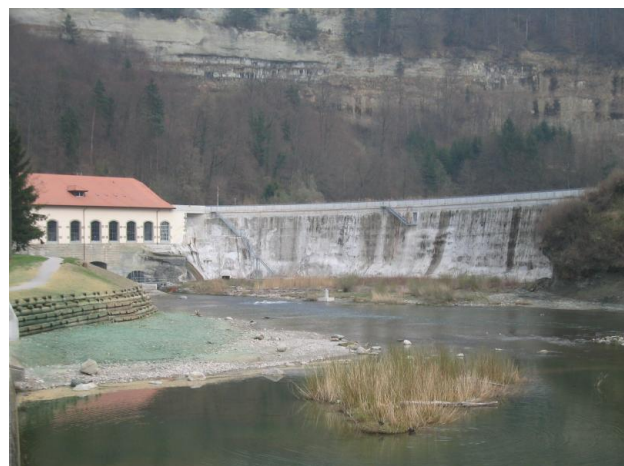
Abb. 8: Europas erste betonierte Gewichtsstaumauer der Mageren Au bei Pérolles südlich von Freiburg, erbaut 1869-1872 und 1910 erweitert [10]
