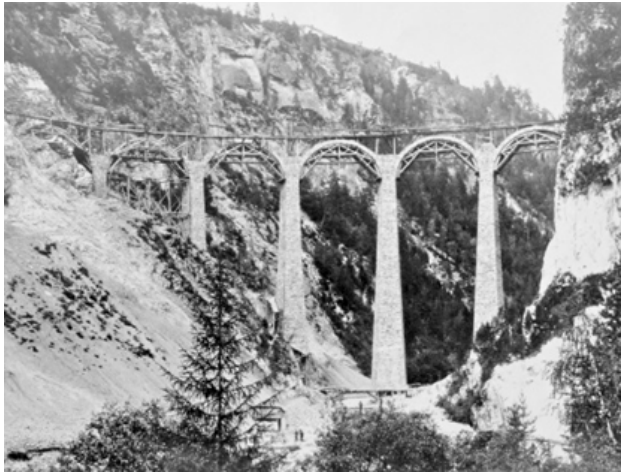
Abb. 5: Landwasserviadukt im Bau, um 1900 [6]
